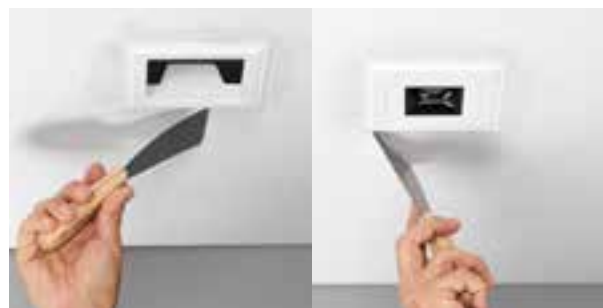
3 - Cubre los huecos con enjarre/revoque/mancillado y limpia la superficie
